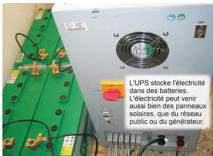
L'UPS stocke l'électricité dans des batteries. L'électricité peut venir aussi bien des panneaux solaires, que du réseau public ou du générateur.
