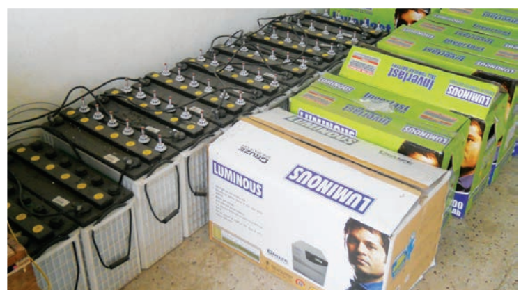
Les panneaux solaires ne seraient pas utiles sans l'UPS (Le système de stockage sur batterie).
